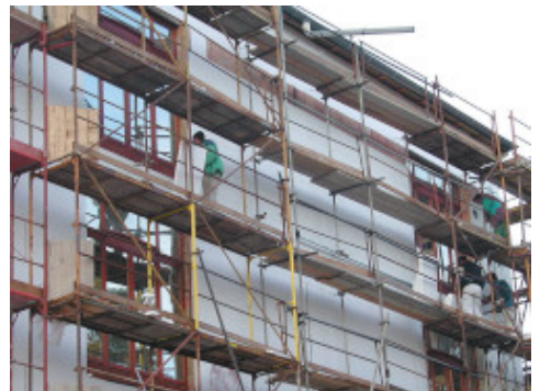
Εφαρμόστε πίεση στις μονωτικές πλάκες μόλις τοποθετηθούν. Έτσι εξασφαλίζεται η καλύτερη συγκόλληση στο υπόστρωμα
