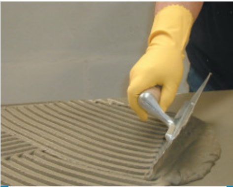
Εφαρμογή του Mapetherm AR1 στην πλάτη της μονωτικής πλάκας με οδοντωτή σπάτουλα
