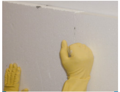
Εφαρμόστε πίεση στις μονωτικές πλάκες μόλις τοποθετηθούν. Έτσι εξασφαλίζεται η καλύτερη συγκόλληση στο υπόστρωμα
