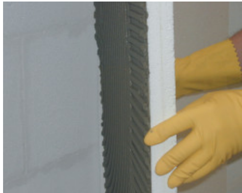
Τοποθέτηση της θερμομονωτικής πλάκας
